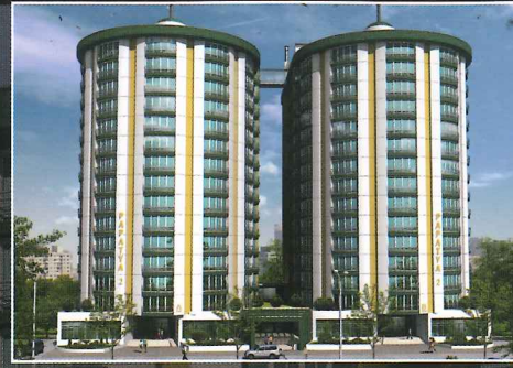
Ön Cephe Görünüm
