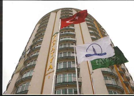
Ön Cephe Görünüm
